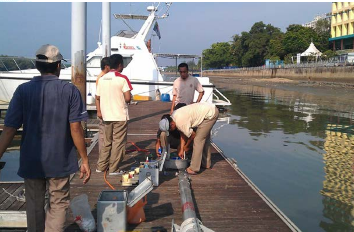
Gambar 4 : Kakitangan Unit Keselamatan Maritim sedang memasang peralatan multibeam.
